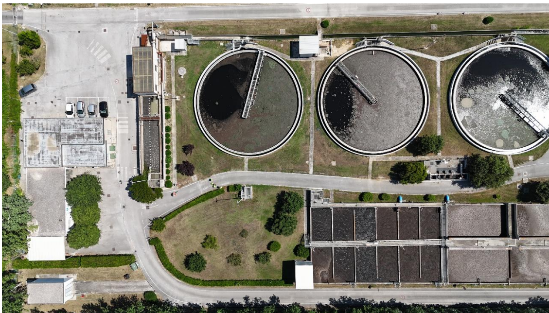
Vista aerea dell'impianto di trattamento delle acque. Fonte: DJI 4 Mini Pro
