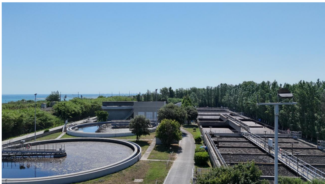
Ingresso dell'impianto di trattamento delle acque (Punto di monitoraggio 1). Fonte: DJI Mini Pro 4
