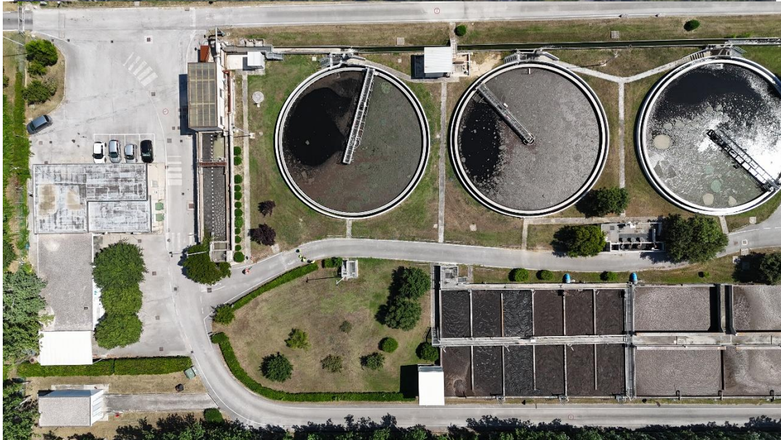
Vista aerea dell'impianto di trattamento delle acque di Fano. Fonte: DJI Mini 4 Pro
