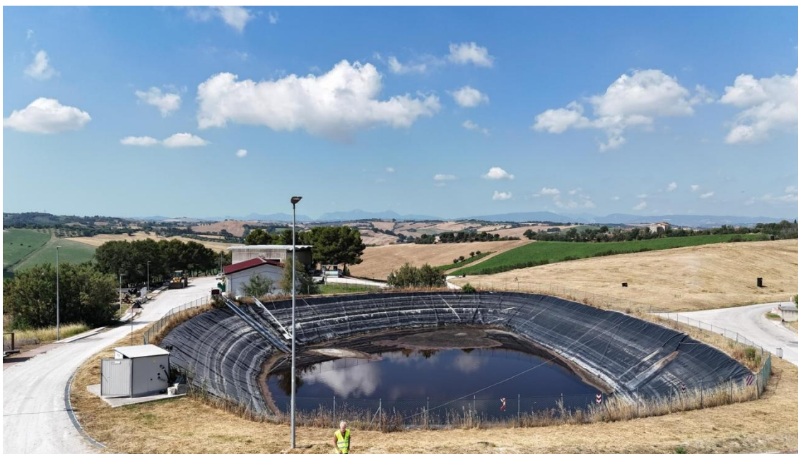
Vasca del percolato (Punto di osservazione 3)
