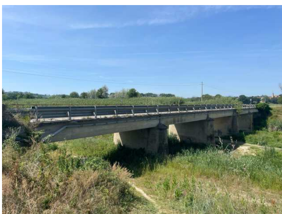
Infrastruttura di collegamento (ponte)
