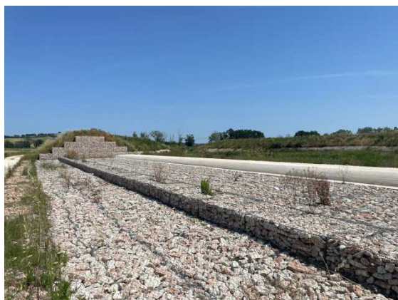
Vasca di espansione
