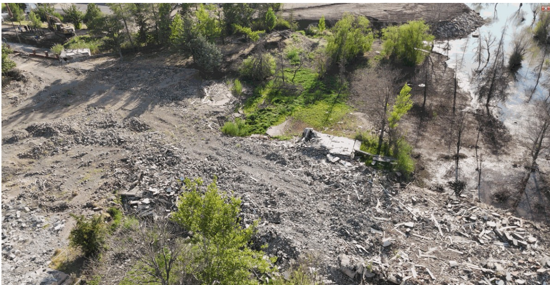
Figura 7. Vista obtida por drone que mostra detritos acumulados, indicando o colapso de estruturas anteriormente existentes após um terremoto.
