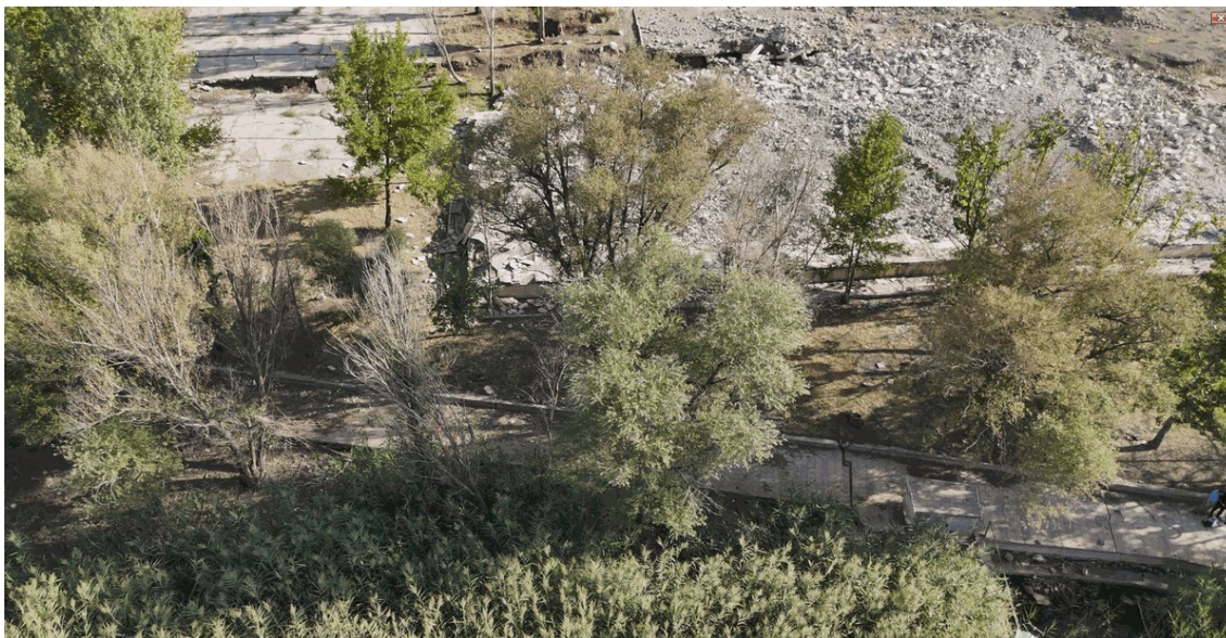
Figura 4. Imagem obtida por drone que mostra um percurso pedonal fissurado junto a terreno saturado após um terremoto.
