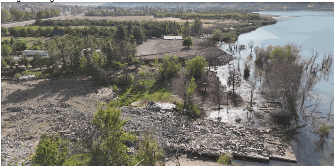
Figura 1. Imagem geral obtida por drone que mostra o espalhamento lateral do solo ao longo da margem do lago após um terramoto.
