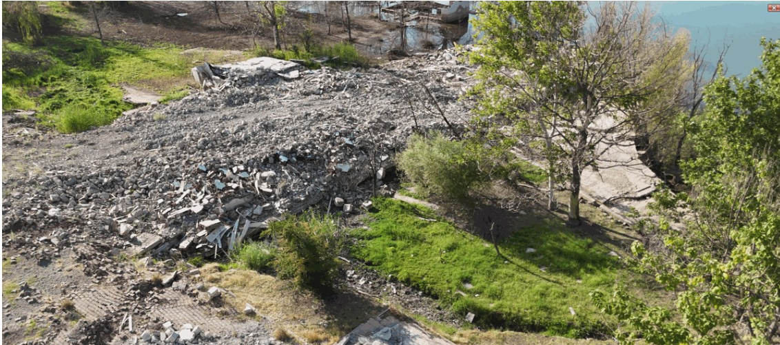
Figura 14. Acumulação de detritos resultantes de colapso e deslocamento da superfície ao longo da encosta junto ao lago, indicando um movimento acentuado do terreno em direção ao lago.
