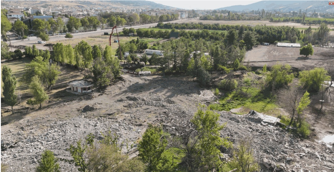
Figura 6. Vista obtida por drone que mostra vegetação e deformação do terreno a progredir em direção à margem do lago após um terremoto.
