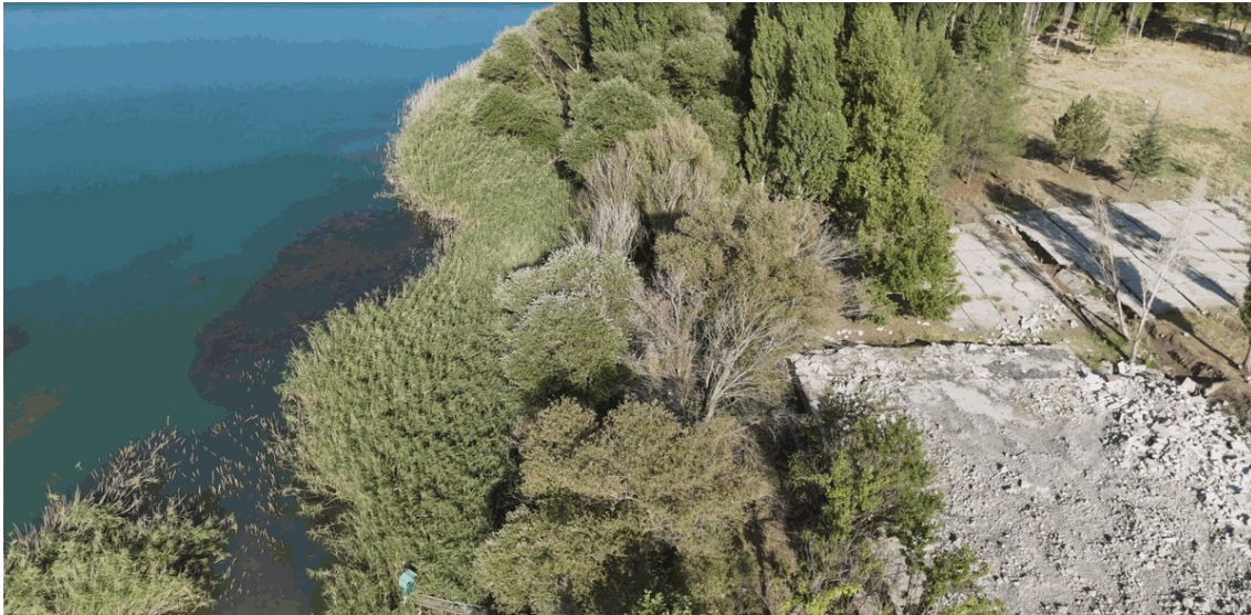
Figura 12. Vista aproximada obtida por drone de lajes de betão fraturadas junto à linha de água, indicando uma rotura localizada associada ao deslocamento lateral do solo.
