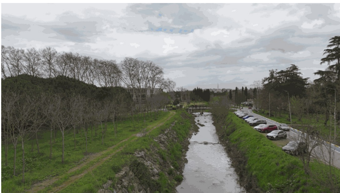
Figura 5. Vista aérea de uma secção de um curso de água adjacente a uma zona urbana, utilizada para a monitorização prática dos níveis da água e a identificação de potenciais zonas de risco de inundação em condições reais.
