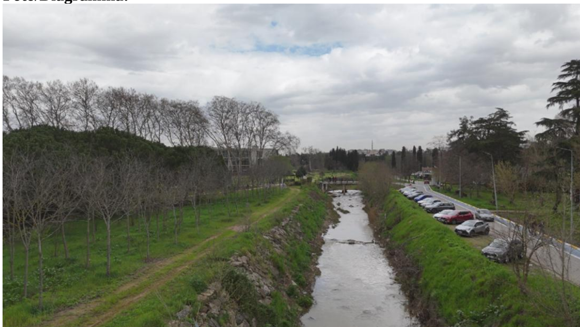
Figura 5. Vista aerea di un tratto di corso d'acqua adiacente a un'area urbana, utilizzata per il monitoraggio pratico dei livelli dell'acqua e l'identificazione di potenziali zone a rischio di inondazioni in condizioni reali.
