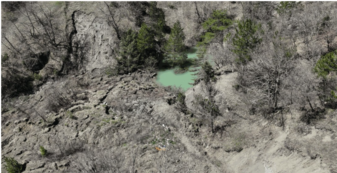
Figura 2. Vista aérea captada por drone de uma área do sopé de um deslizamento de terras, mostrando a acumulação de água, ravinas de erosão e efeitos de socavamento causados pelo escoamento superficial. A imagem evidencia como os processos provocados pela água removem material na base do talude, reduzindo potencialmente a sua estabilidade.
