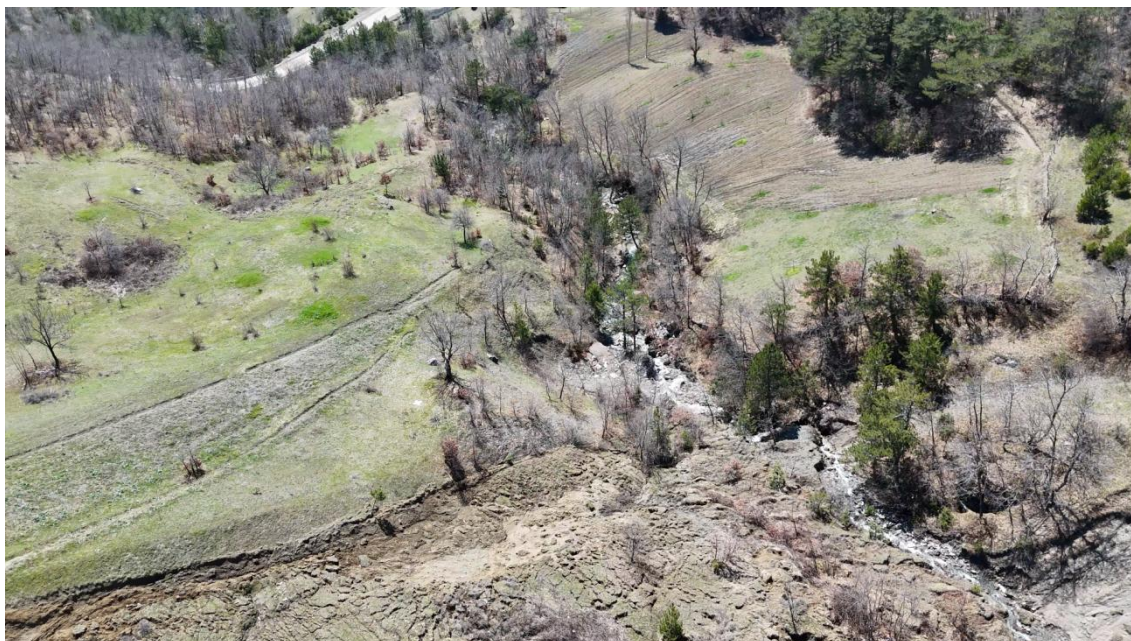
Figura 5. Vista obliqua del drone che mostra l'interazione tra il pendio della frana e il corso d'acqua adiacente. Il flusso canalizzato e l'erosione localizzata del versante lungo il corso d'acqua indicano processi di erosione in corso, mentre il trasporto di sedimenti dal pendio verso il canale evidenzia l'accoppiamento tra instabilità del pendio e dinamica fluviale.
