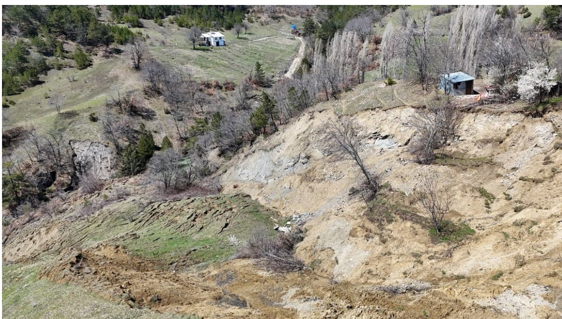
Figura 4. Vista aérea ampla de um deslizamento de terras, mostrando a escarpa principal, a superfície de deslizamento rotacional e a área do pé, ilustrando a geometria global da rutura da vertente e as principais características utilizadas na análise visual.
