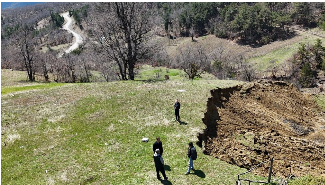
Figura 2. Vista geral de uma área afetada por um deslizamento de terras, mostrando uma escarpa íngreme e as condições do terreno nas proximidades, ilustrando zonas potencialmente inseguras e os riscos associados à aproximação a terrenos danificados após um sismo.
