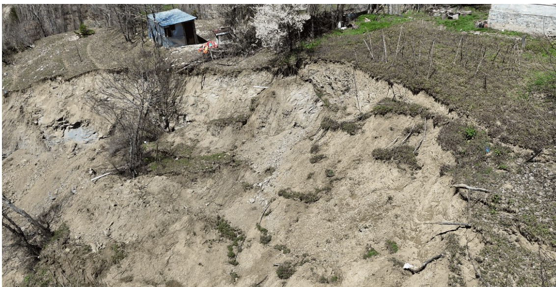
Figura 5. Vista obtida por drone, mostrando uma área afetada por um deslizamento de terras com múltiplas superfícies de rutura e deslocamento do solo, destacando padrões visíveis de instabilidade e a proximidade de estruturas próximas.
