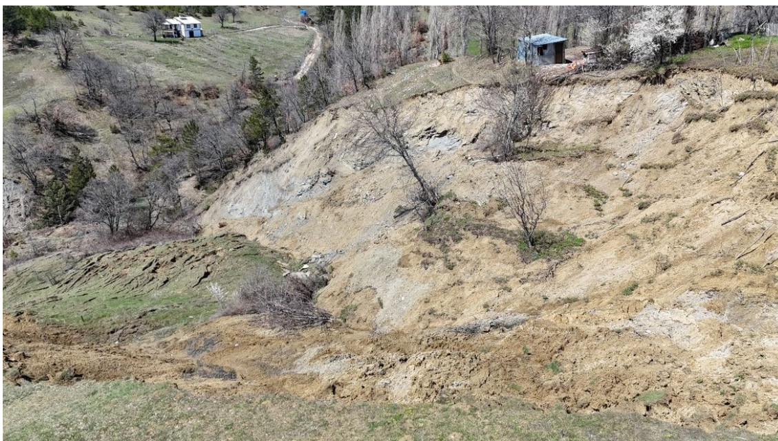
Figura 7. Vista geral obtida por drone de um deslizamento de terras, mostrando múltiplas superfícies de rutura, deslocamento do solo e instabilidade progressiva da vertente, proporcionando um exemplo claro para identificar e comparar diferentes padrões de danos.
