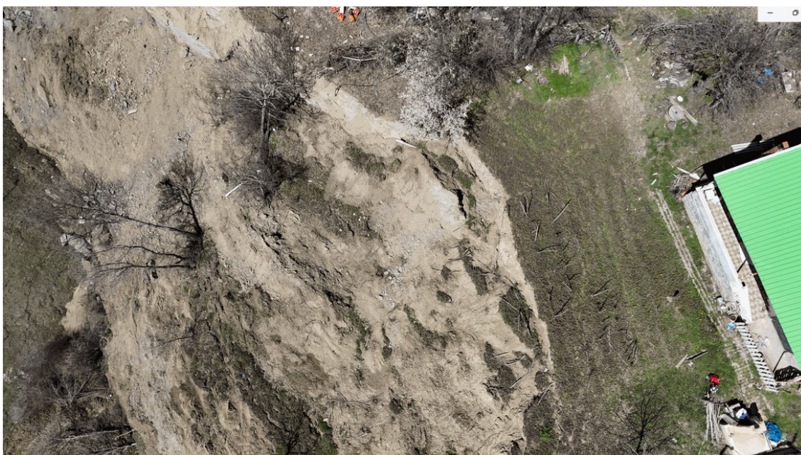
Figura 15. Vista zenital, obtida por drone, de uma área de deslizamento de terras, mostrando a principal zona de rutura, os padrões de deslocamento de materiais e a proximidade de uma estrutura residencial, contribuindo para uma inspeção detalhada e para a avaliação de riscos.
