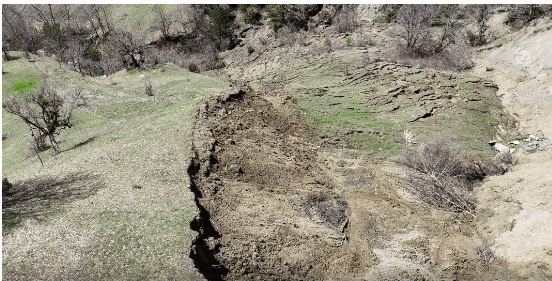
Figura 8. Vista aproximada obtida por drone da escarpa de cabeceira de um deslizamento de terras e da massa de solo deslocada, distinguindo claramente o terreno estável das zonas de rutura e ilustrando as principais características da instabilidade da vertente.
