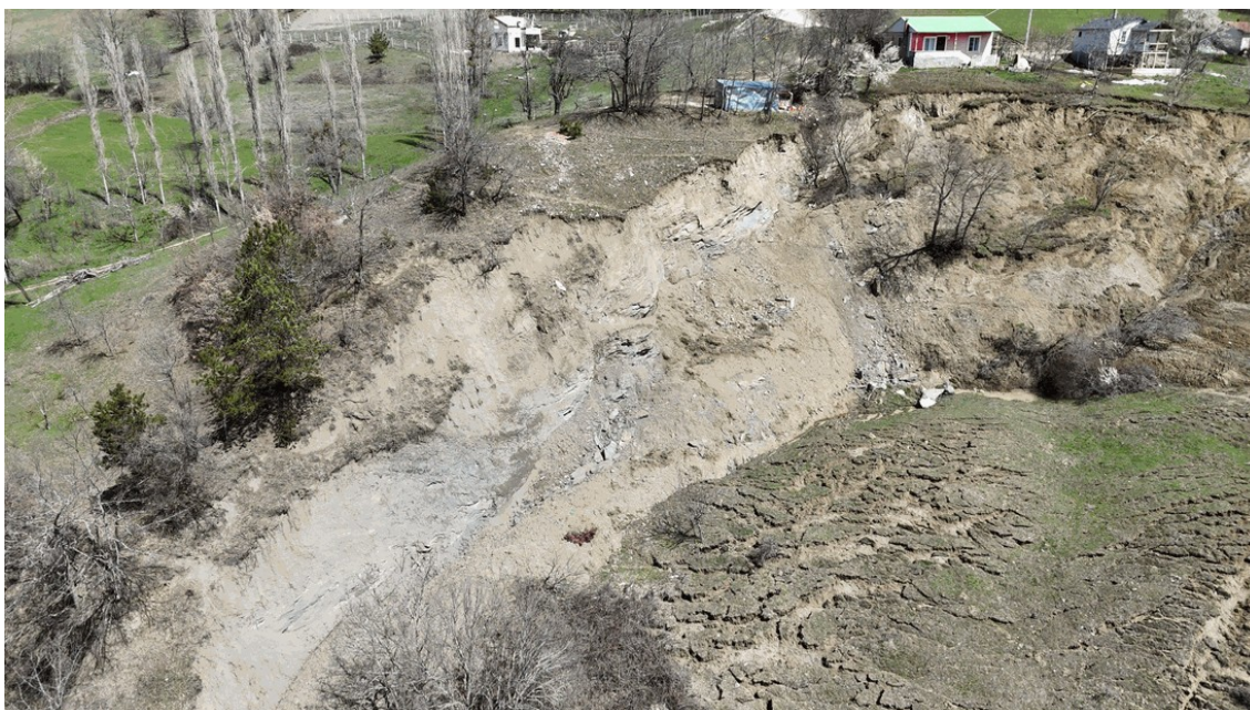
Figura 13. Vista aproximada, obtida por drone, da escarpa principal de um deslizamento de terras, mostrando camadas de solo expostas, a superfície de deslizamento e zonas de deformação, e destacando áreas de elevada instabilidade próximas de estruturas residenciais.
