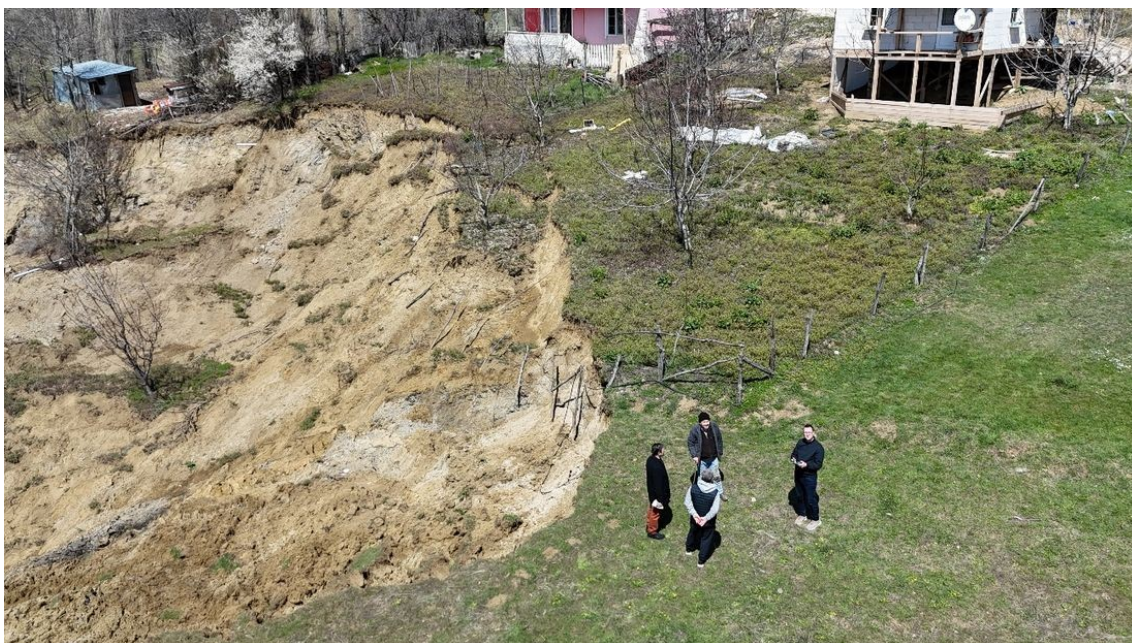
Figura 6. Vista obtida por drone, mostrando uma escarpa de deslizamento de terras e o deslocamento progressivo do solo junto a uma estrutura residencial, destacando a instabilidade do terreno e o risco potencial para as infraestruturas próximas.
