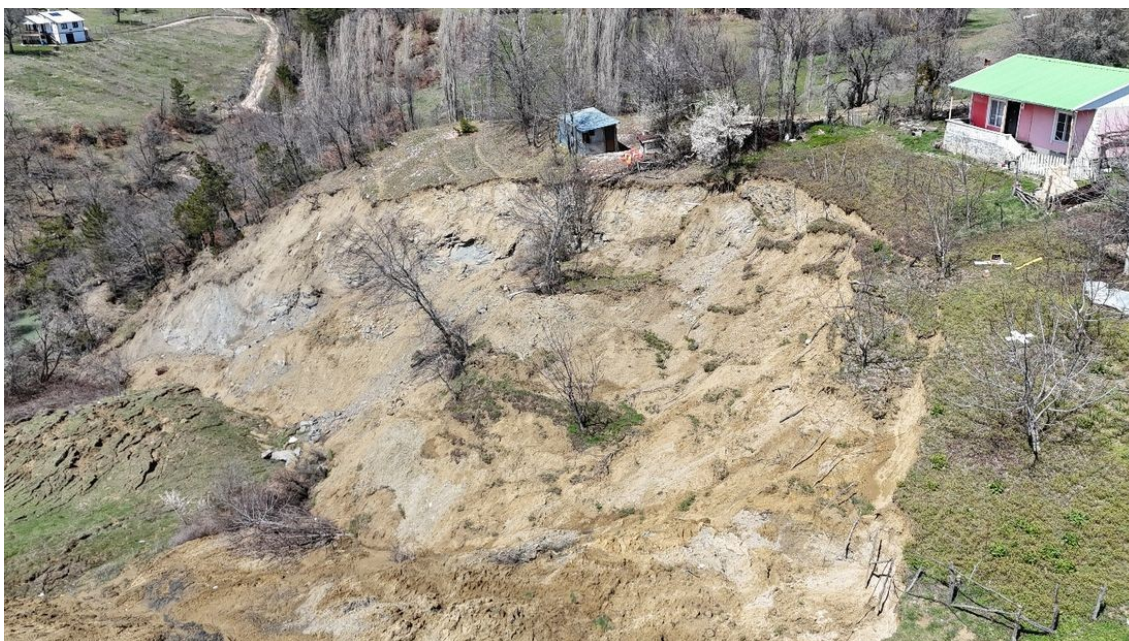
Figura 3. Vista aérea de uma área afetada por um deslizamento de terras, mostrando a escarpa principal, as massas de solo deslocadas e a proximidade da zona de rutura relativamente às estruturas residenciais próximas, destacando potenciais áreas de risco identificadas durante a inspeção visual.
