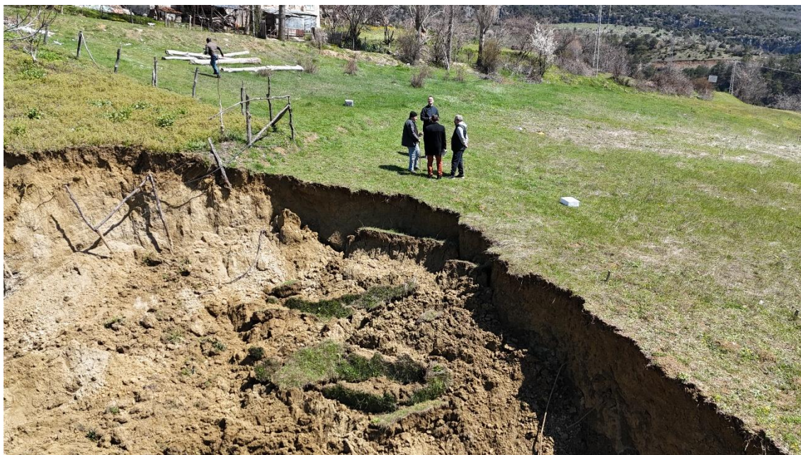
Figura 1. Vista a livello del suolo che mostra individui in piedi vicino al bordo di una scarpata di frana attiva, illustrando condizioni non sicure e l'importanza di mantenere distanze di sicurezza durante l'ispezione.
