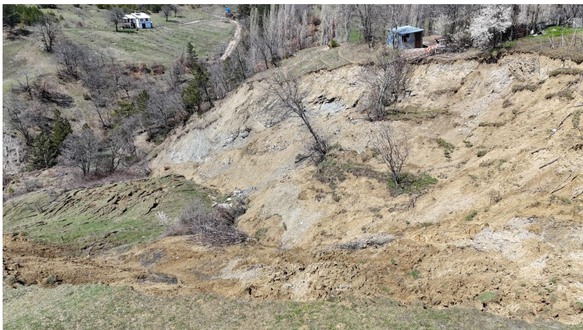
Figura 6. Vista basata su drone che mostra una scarpata di frana e un progressivo spostamento del suolo vicino a una struttura residenziale, evidenziando l'instabilità del terreno e il potenziale rischio per le infrastrutture vicine.
