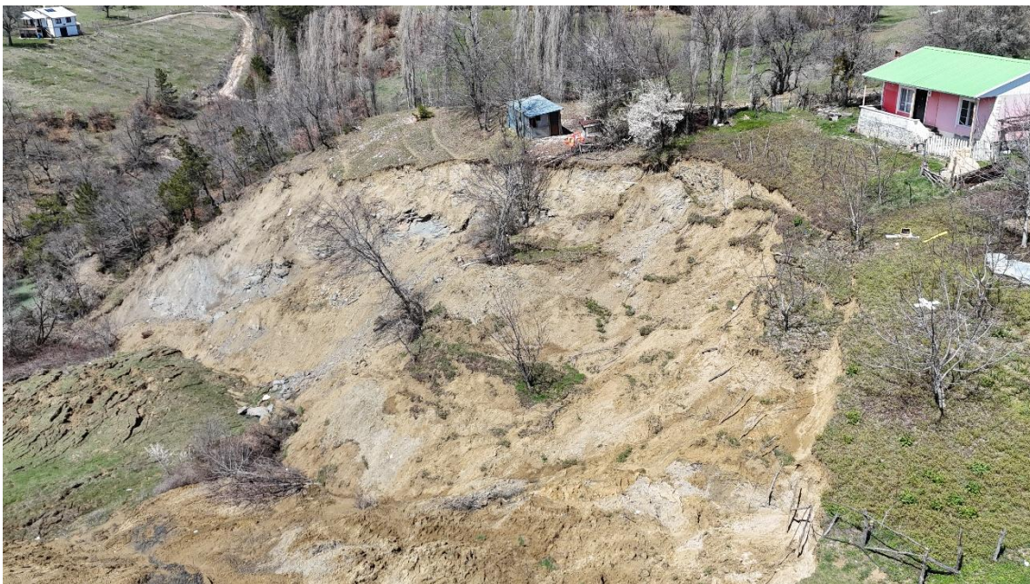
Figura 3. Vista aerea di un'area di frana che mostra la scarpata principale, le masse di terreno spostate e la vicinanza della zona di cedimento alle strutture residenziali vicine, evidenziando le potenziali aree a rischio identificate durante l'ispezione visiva.
