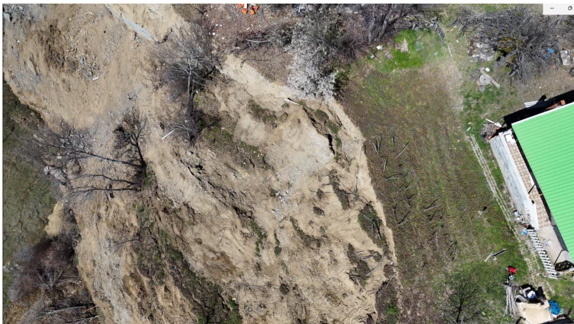
Figura 15. Vista dall'alto di un'area franata con drone, che mostra la zona di rottura principale, i modelli di spostamento dei materiali e la vicinanza a una struttura residenziale, supportando un'ispezione dettagliata e una valutazione del rischio.
