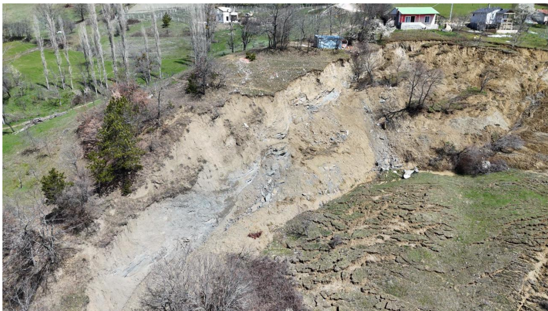
Figura 13. Vista ravvicinata tramite drone della scarpata principale di una frana, che mostra gli strati di terreno esposti, la superficie di scivolamento e le zone di deformazione, evidenziando le aree di elevata instabilità in prossimità delle strutture residenziali.
