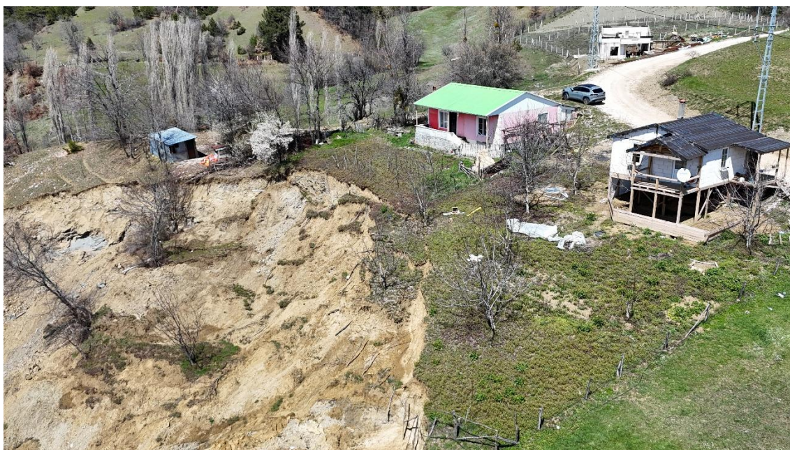
Figura 10. Vista aerea che mostra una frana attiva in prossimità di abitazioni residenziali, evidenziando le zone ad alto rischio e il potenziale impatto dell'instabilità del pendio sulle strutture vicine durante il processo di ispezione.
