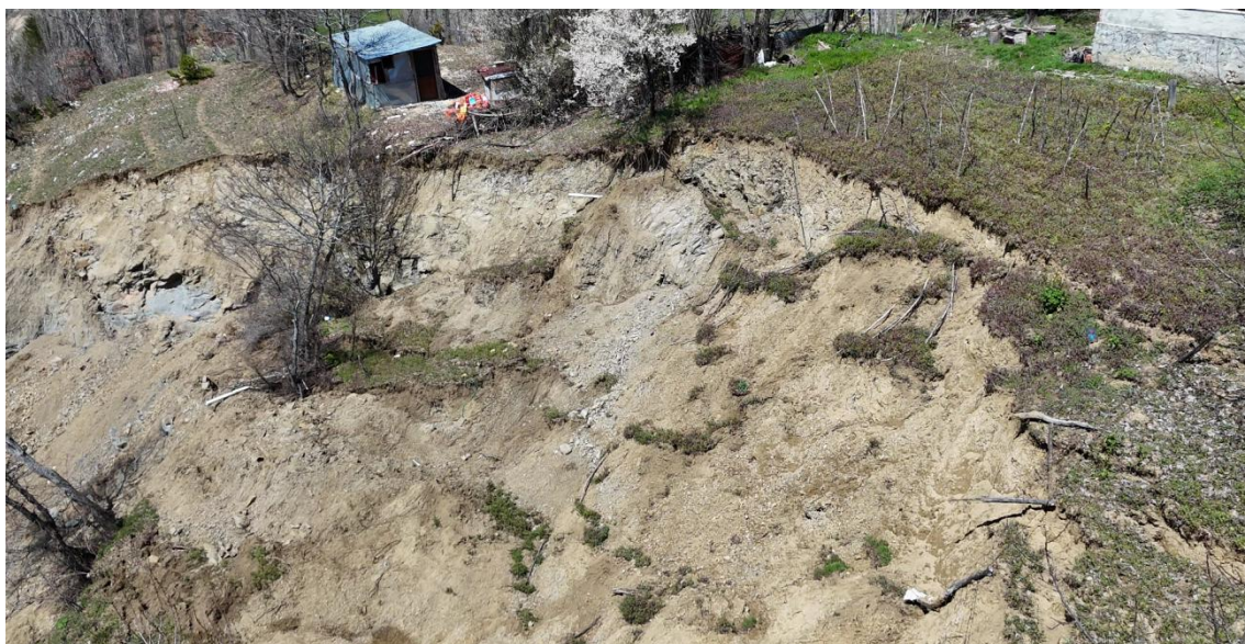
Figura 4. Ampia vista aerea di una frana che mostra la scarpata principale, la superficie di scorrimento rotazionale e l'area della punta, illustrando la geometria complessiva del cedimento del pendio e le caratteristiche principali utilizzate per l'analisi visiva.
