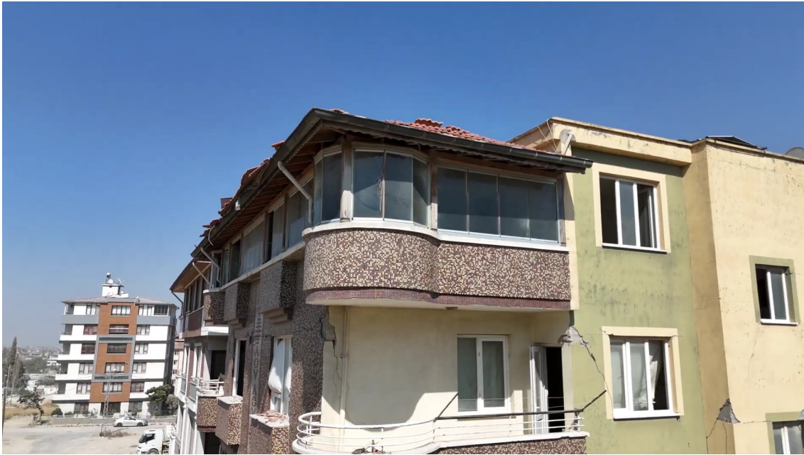
Şekil 6. Komşu binalara kıyasla cephenin eğriliği ve çatı çizgisinin kaymasını gösteren eğik dron görüntüsü.
