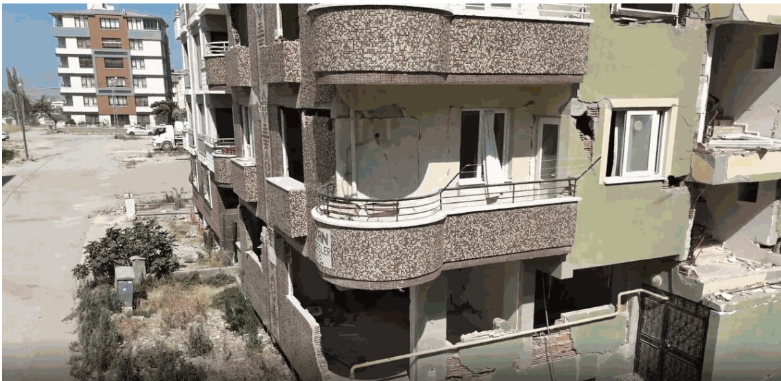
Obrázok 4. Bočný pohľad zobrazujúci účinky torzného namáhania na rohové stĺpy a balkóny budovy po zemetrasení.
