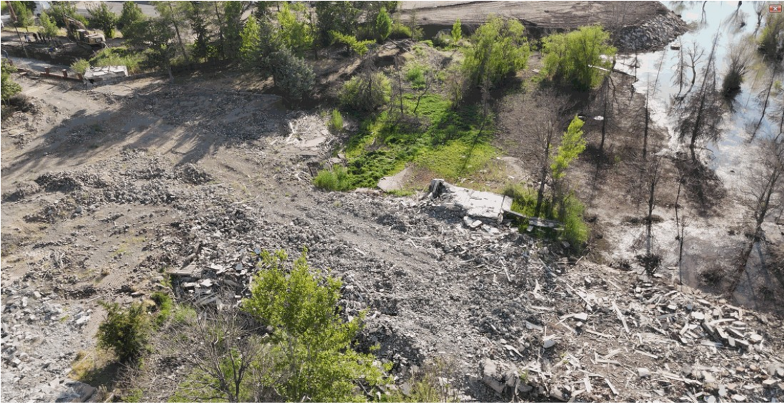
Şekil 7. Deprem sonrasında eski yapıların çöktüğünü gösteren birikmiş enkazın dron görüntüsü.
