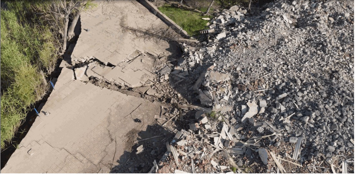
Şekil 17. Yerinden kaymış istinat duvarı ve hizasız ağaç sıraları, toprağın yana doğru yayılmasını ve göl kıyısına doğru farklı yönlü zemin hareketini göstermektedir.
