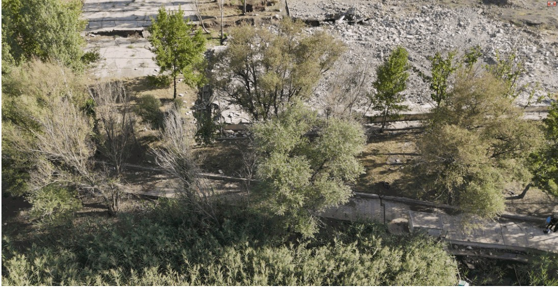
Şekil 4. Deprem sonrasında suyla doymuş zeminin yanındaki çatlaklı yaya geçidini gösteren dron görüntüsü.
