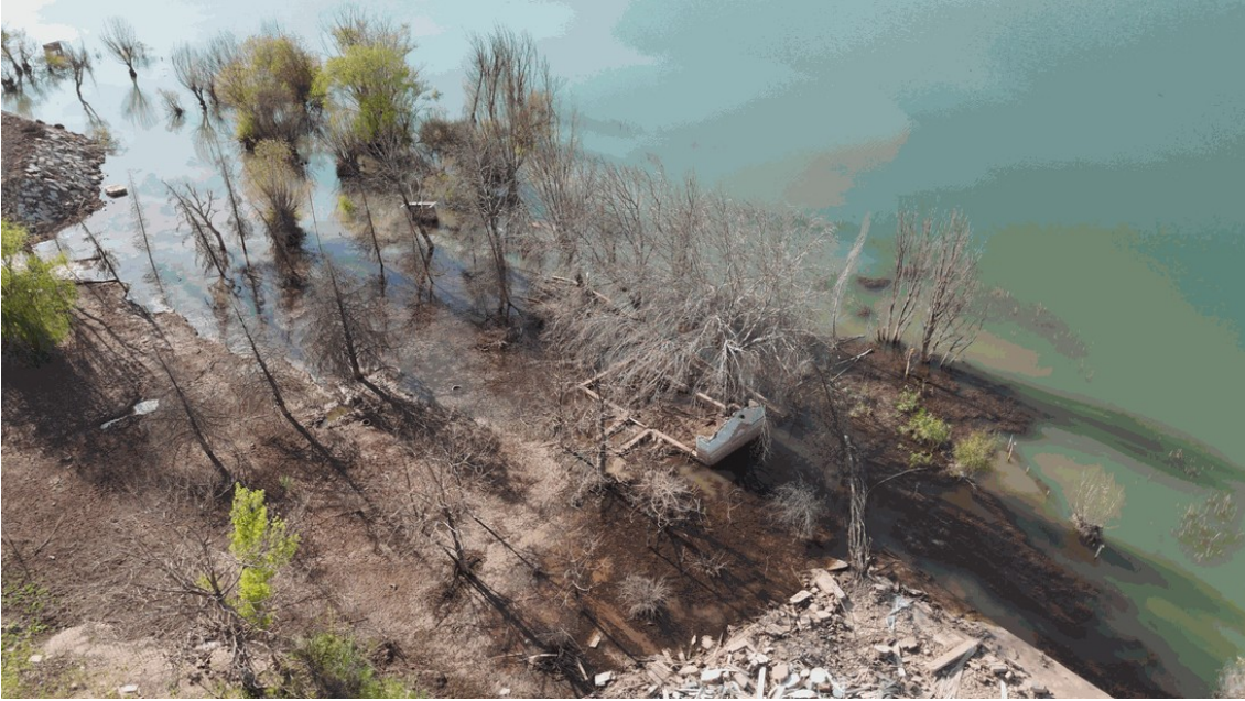
Şekil 9. Deprem sonrasında yüzeyinde belirgin bir kayma görülen, çökmüş göl kenarı kaldırımını gösteren drone görüntüsü.
