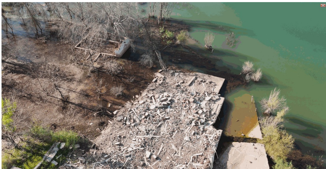
Obrázok 13. Záber z dronu zobrazujúci zrútenú konštrukciu na brehu jazera čiastočne zaplavenú vodou v dôsledku bočného rozširovania a posunu pôdy.
