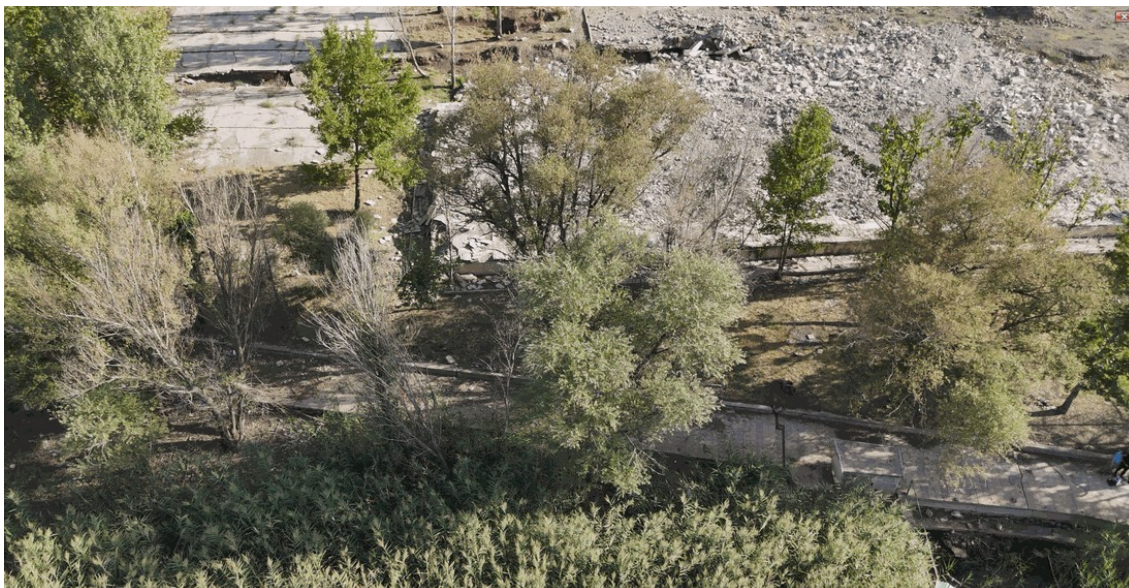
Obrázok 4. Záber z dronu zobrazujúci popraskaný peší chodník v susedstve vodou nasýteného terénu po zemetrasení.
