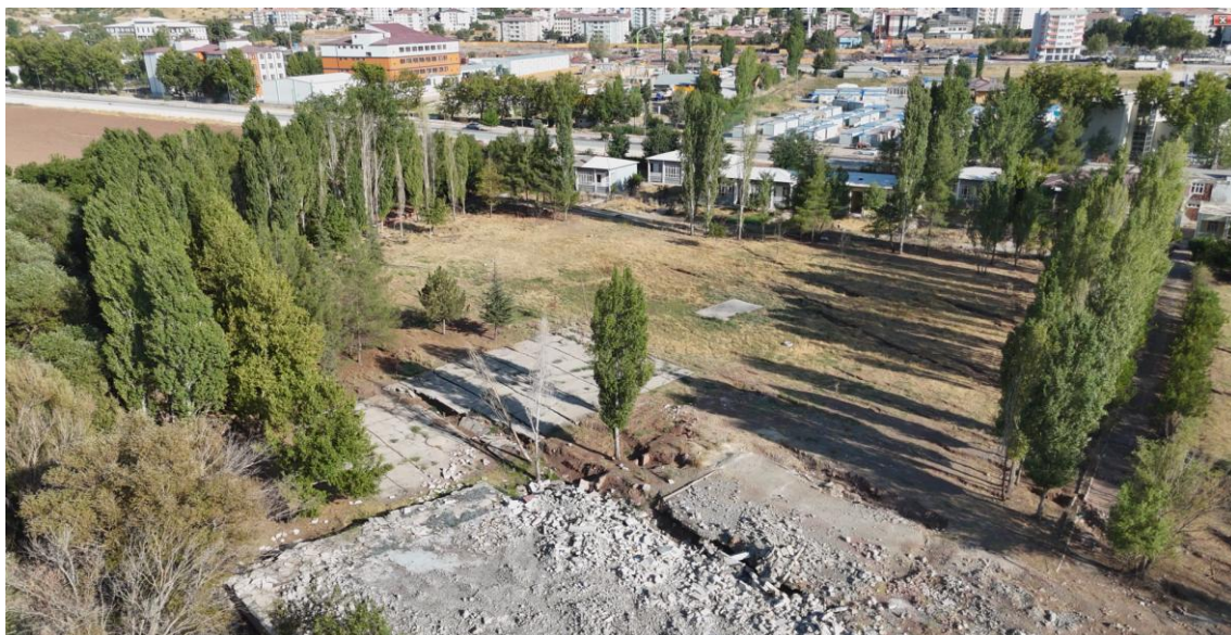
Figura 10. Immagine aerea ripresa da un drone che mostra il terreno spostato dietro la zona di cedimento in riva al lago, indicando la direzione dell'espansione laterale e l'accumulo di detriti residui dopo un terremoto.
