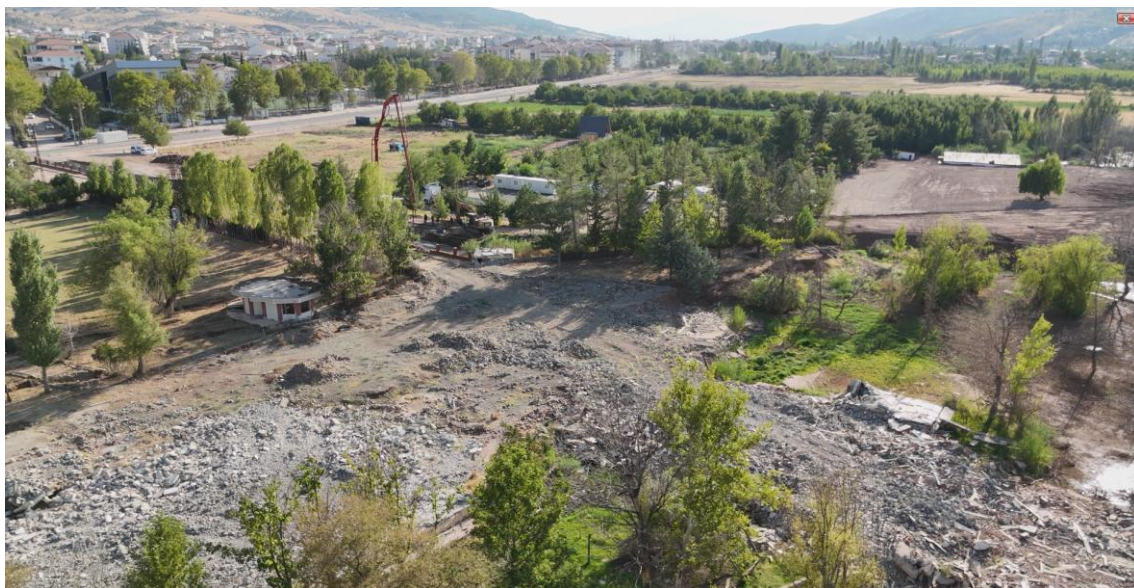
Figura 6. Riprese aeree effettuate con un drone che mostrano la vegetazione e la deformazione del terreno in progressione verso la riva del lago dopo un terremoto.
