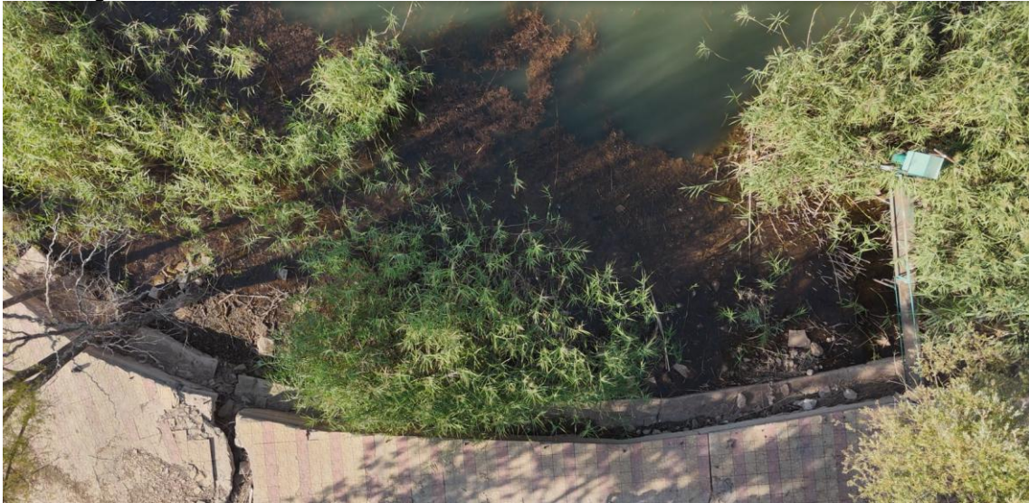
Figura 2. Riprese aeree effettuate con un drone che mostrano le prime fessurazioni e cedimenti del terreno lungo una pavimentazione in riva al lago dopo un terremoto.
