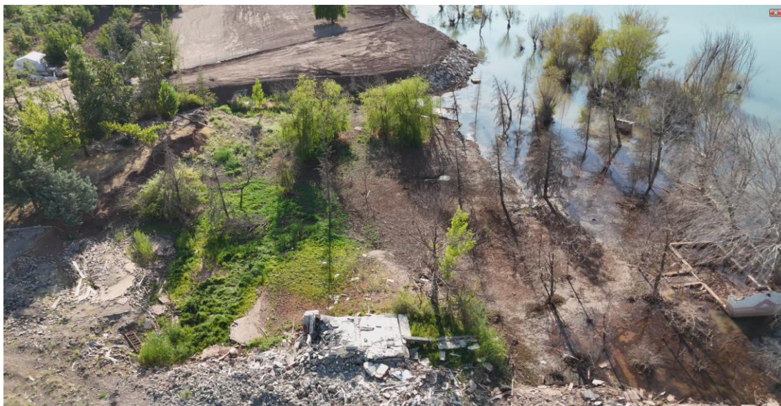
Figura 8. Ripresa obliqua da un drone che mostra una zona di spostamento mista di suolo e vegetazione in seguito a un terremoto.
