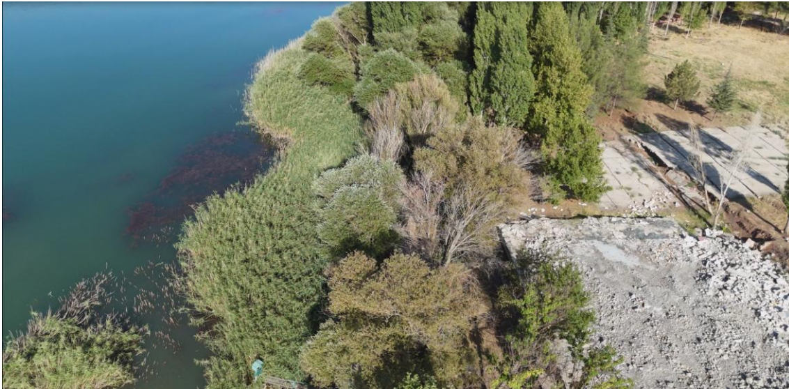
Figura 12. Ripresa ravvicinata da un drone di lastre di cemento fratturate vicino al livello dell'acqua, che indicano una rottura localizzata associata allo spostamento laterale del terreno.
