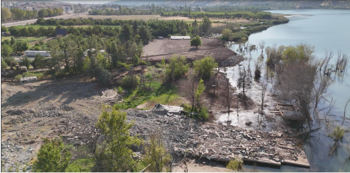
Figura 1. Immagine aerea ripresa da un drone che mostra l'espansione laterale del terreno lungo la riva del lago in seguito a un terremoto.
