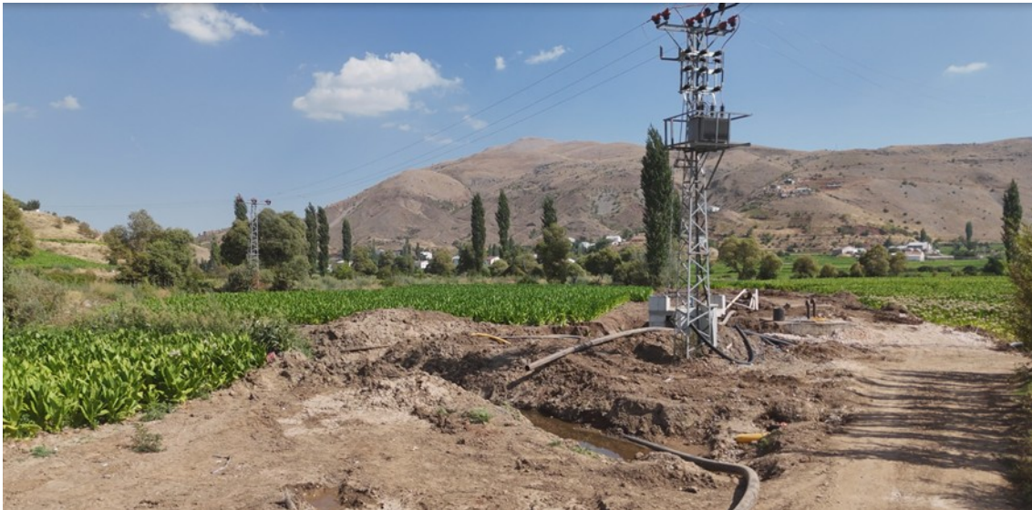
Figura 1. Vista geral de um local de transporte de água e da respetiva envolvente, ilustrando o tipo de infraestrutura e as condições no terreno que podem ser afetadas após um sismo e exigir uma inspeção visual segura e à distância.
