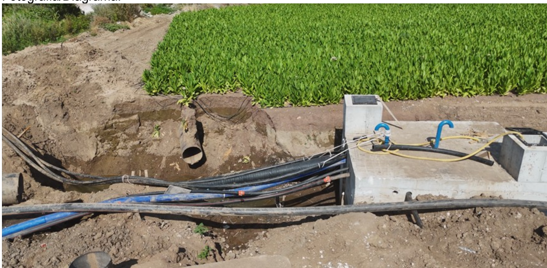
Figura 5. Imagem de grande plano captada por drone, mostrando danos visíveis no interior de uma estrutura de transporte de água, incluindo ligações deslocadas, utilizada para inspeção visual detalhada e documentação durante a avaliação prática.
