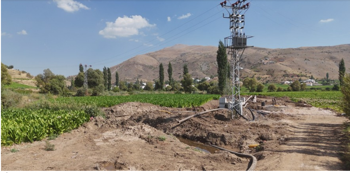
Şekil 1. Bir su iletim tesisinin ve çevresinin genel görünümü; deprem sonrasında etkilenebilecek ve güvenli, uzaktan görsel inceleme gerektirebilecek altyapı türlerini ve saha koşullarını göstermektedir.
