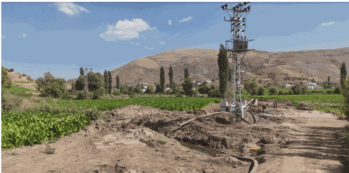
Obrázok 1. Celkový pohľad na vodnú dopravnú stavbu a jej okolité prostredie ilustrujúci typ infraštruktúry a podmienky v teréne, ktoré môžu byť po zemetrasení poškodené a vyžadujú bezpečnú diaľkovú vizuálnu kontrolu pomocou dronu.
