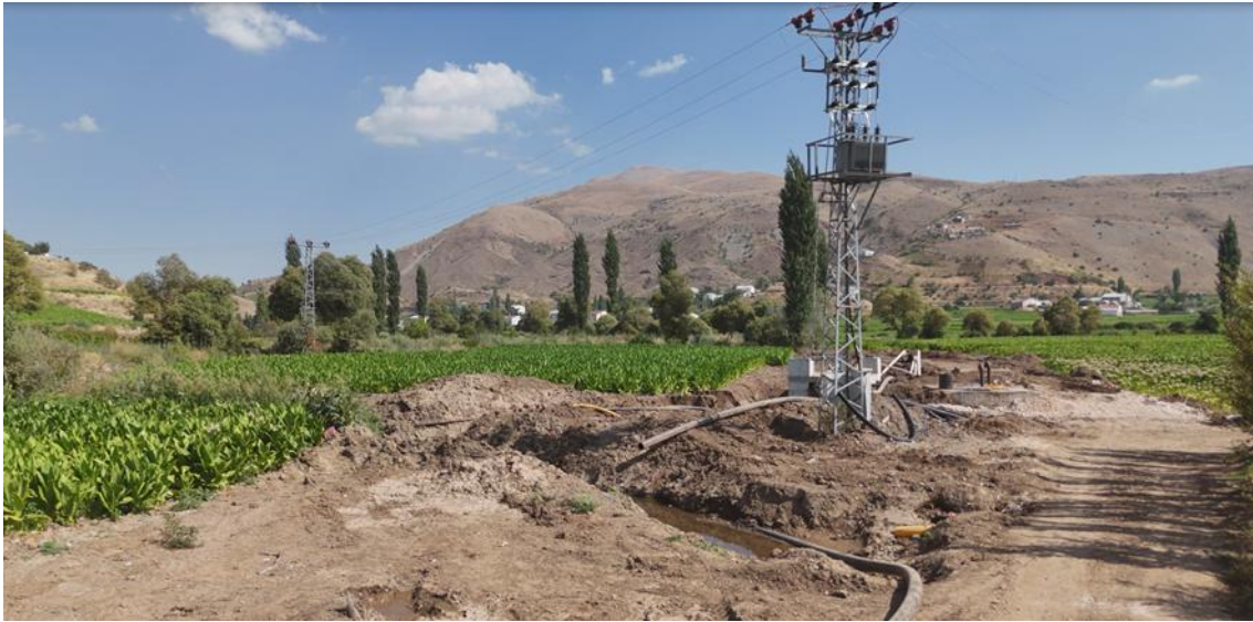
Figura 1. Veduta generale di un sito di trasmissione idrica e dell'ambiente circostante, che illustra il tipo di infrastrutture e le condizioni del terreno che potrebbero essere interessate da un terremoto e che richiedono un'ispezione visiva a distanza in sicurezza.
