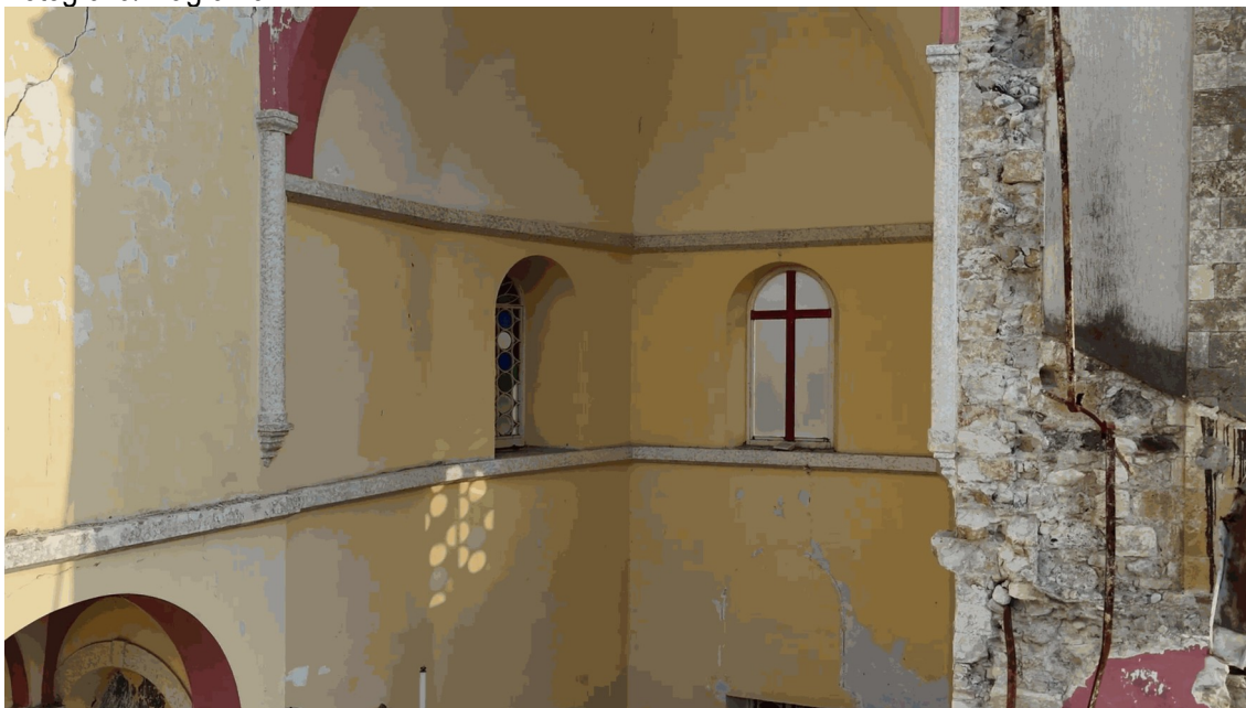
Figura 4. Vista interior que mostra danos visíveis relacionados com sismos nas superfícies e áreas decorativas de uma estrutura histórica.
