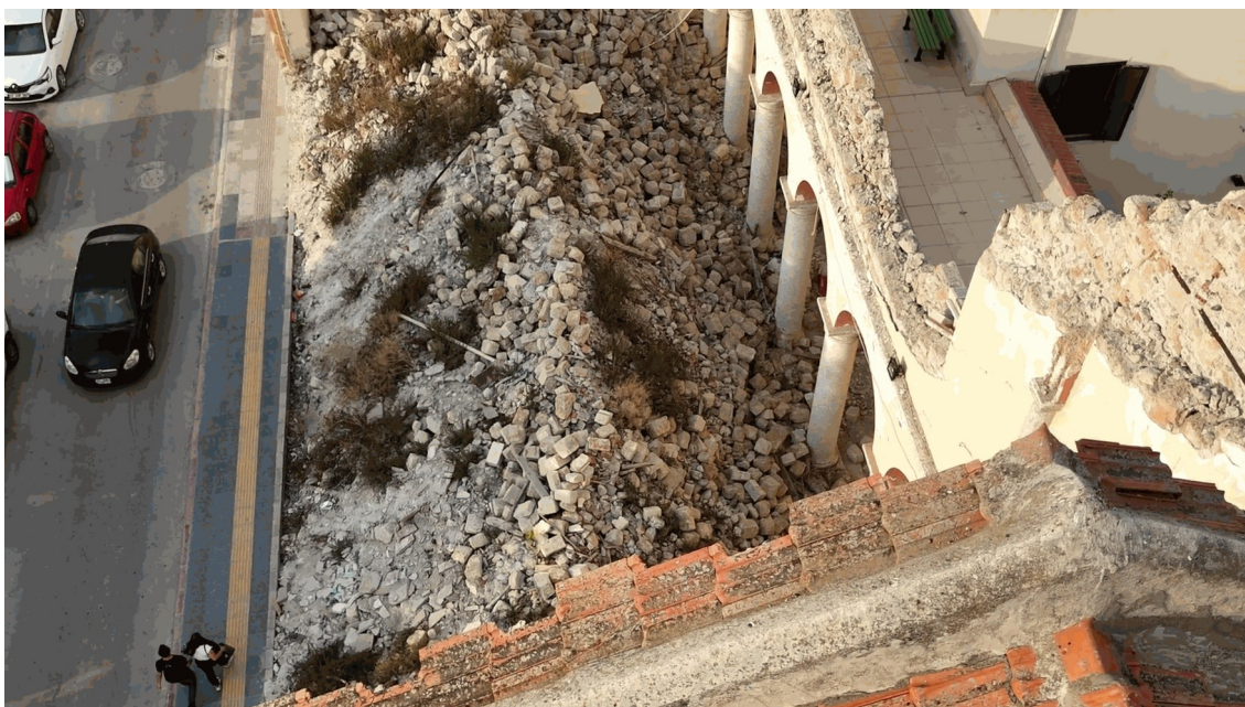
Figura 10. Vista vertical obtida por drone que mostra o colapso relacionado com um sismo e a acumulação de detritos no interior de uma estrutura histórica durante a inspeção visual.
