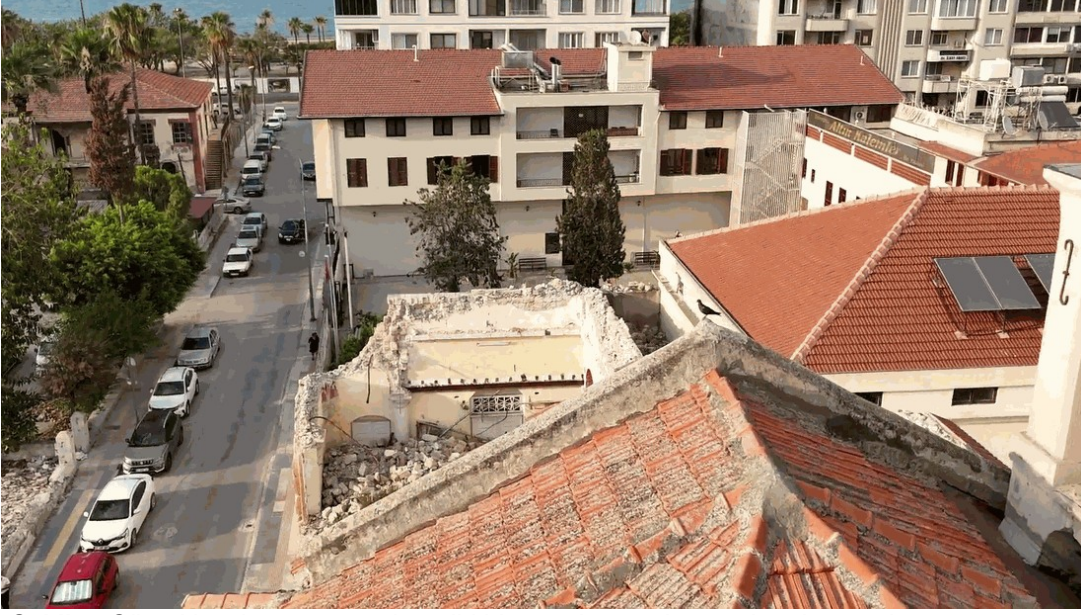
Şekil 8. Görsel inceleme sırasında tarihi bir yapıda meydana gelen deprem hasarını ve çevresel durumu gösteren dron görüntüsü.
