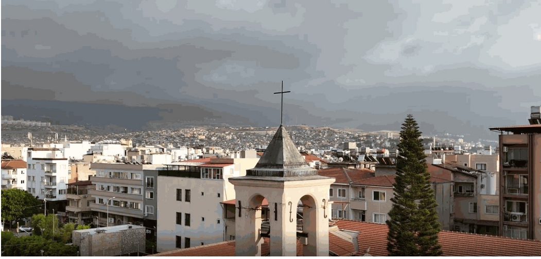
Şekil 2. Depremden sonra tarihi bir yapının çevresindeki kent dokusu içindeki görünümünü gösteren havadan çekilmiş bir fotoğraf.
