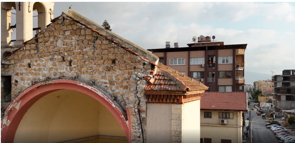
Obrázok 12. Pohľad z dronu zachytený počas záverečného preletu, zobrazujúci nestabilitu horných častí historickej stavby spôsobenú zemetrasením.
