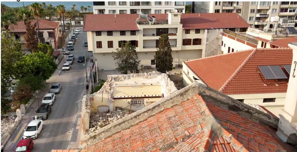
Figure 8. Celkový pohľad z dronu zobrazujúci historickú stavbu poškodenú zemetrasením a jej okolité prostredie počas vykonávania vizuálnej kontroly.
