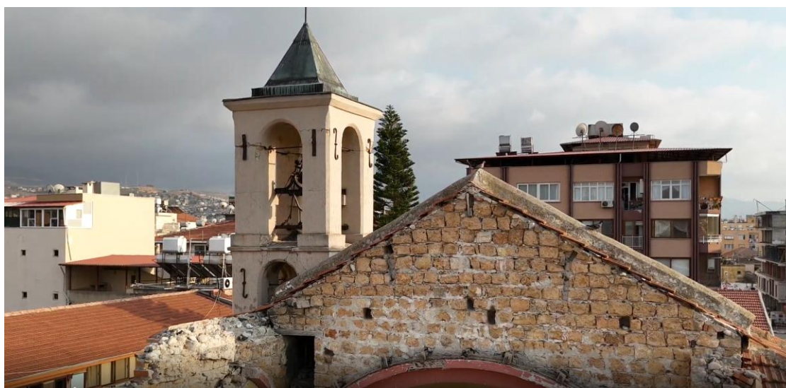
Figura 9. Ripresa aerea a media altezza con drone, utilizzata per documentare i danni visibili causati dal terremoto sulle parti superiori di una struttura storica durante un'ispezione.
