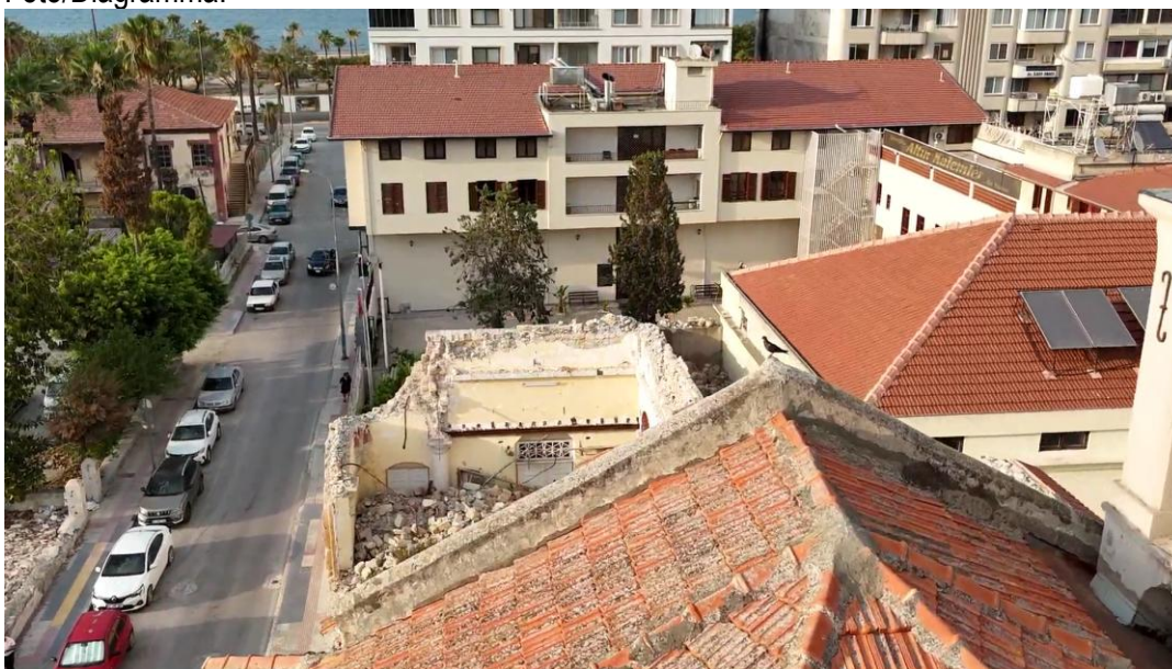
Figura 8. Riprese aeree effettuate con un drone che mostrano i danni causati dal terremoto a una struttura storica e al contesto circostante, durante un'ispezione visiva.
