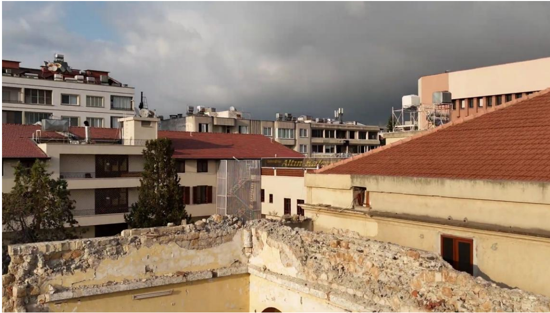
Figura 3. Vista contestuale che mostra la relazione tra una struttura storica danneggiata e gli edifici circostanti dopo un terremoto.
