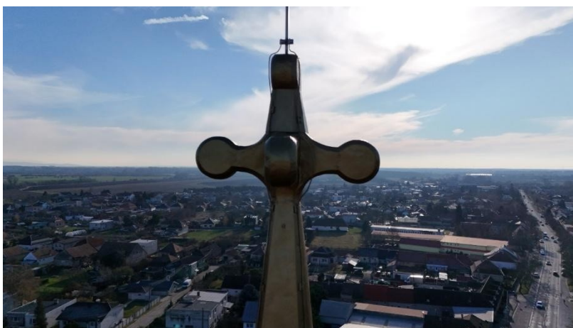
Fig. Vista a partir do drone do ponto de medição – aquisição de coordenadas
