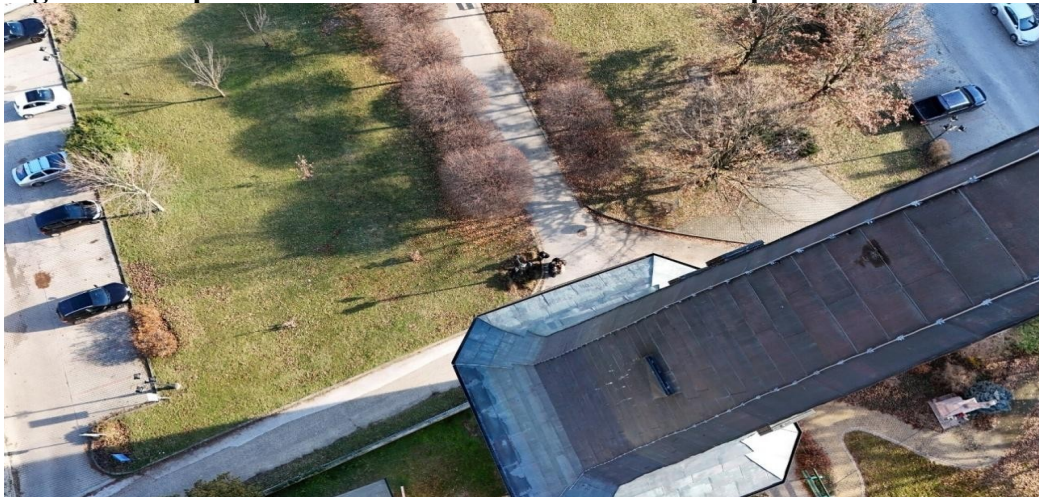
Fig. Vista del punto di misurazione tramite drone – acquisizione delle coordinate
