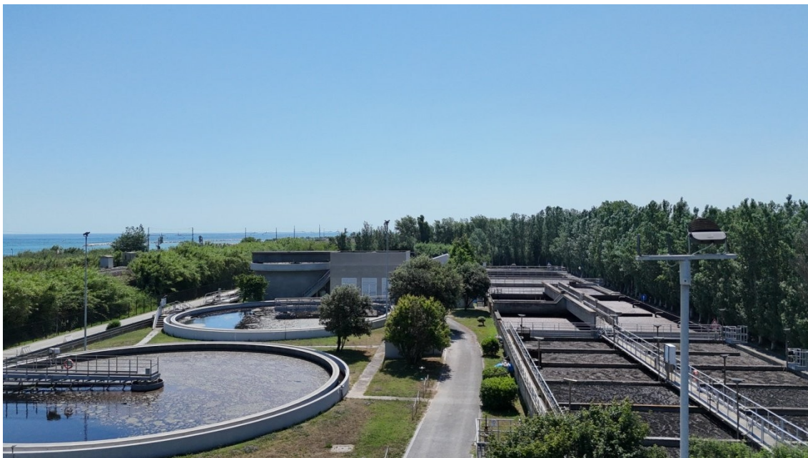
Vstup do čistiarne odpadových vôd (monitorovací bod 1). Zdroj: DJI Mini Pro 4
