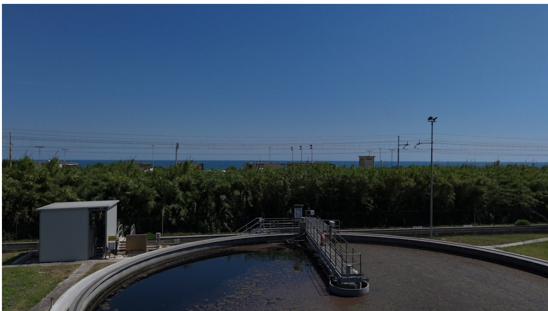
Čistiareň odpadových vôd (monitorovací bod 3). Zdroj: DJI Mini Pro 4
