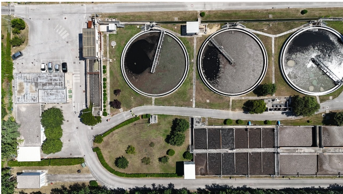
Letecký pohľad na čistiareň odpadových vôd. Zdroj: DJI 4 Mini Pro
