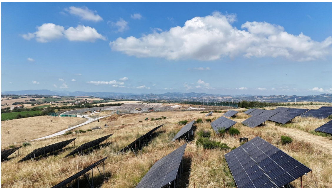
Rekultivované teleso komunálneho odpadu (pozorovací bod 2)
