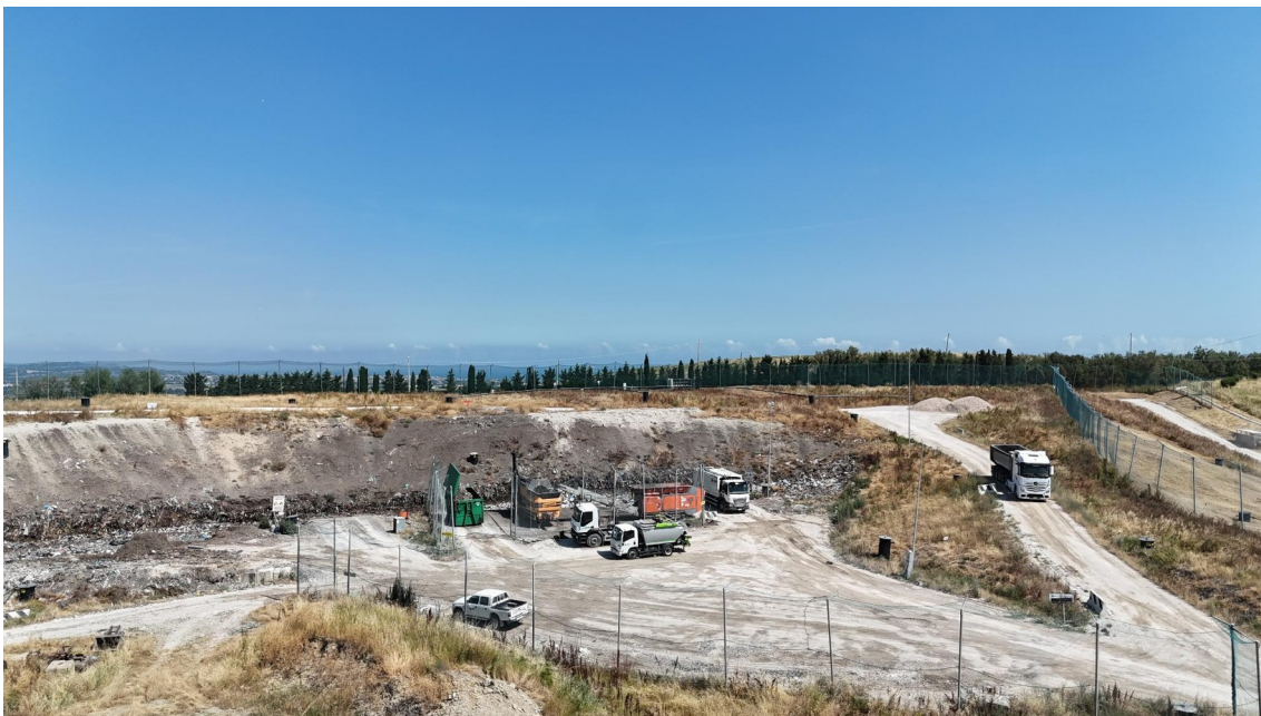
Priestor ukladania komunálneho odpadu (pozorovací bod 4)
